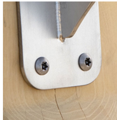
Schrauben aus rostfreiem Stahl und/oder Schrauben mit Kunststoffkappen,
